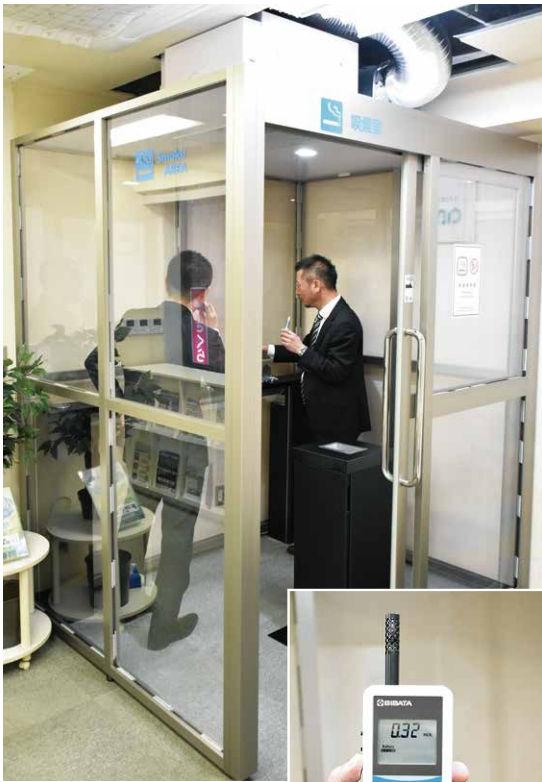
「スモブT-1」は風速0.2m/秒以上が維持されており技術基準をクリア。スライドドア式で出入りも楽々。写真は4~6人用のキューブミニタイプ。
